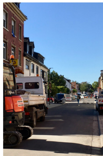
Endspurt – letzte Bauarbeiten
