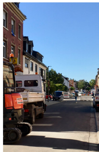
Endspurt – letzte Bauarbeiten
